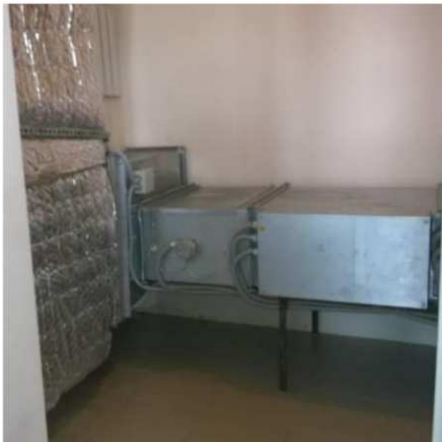
Вентиляционная камера 13,5 м.кв.
